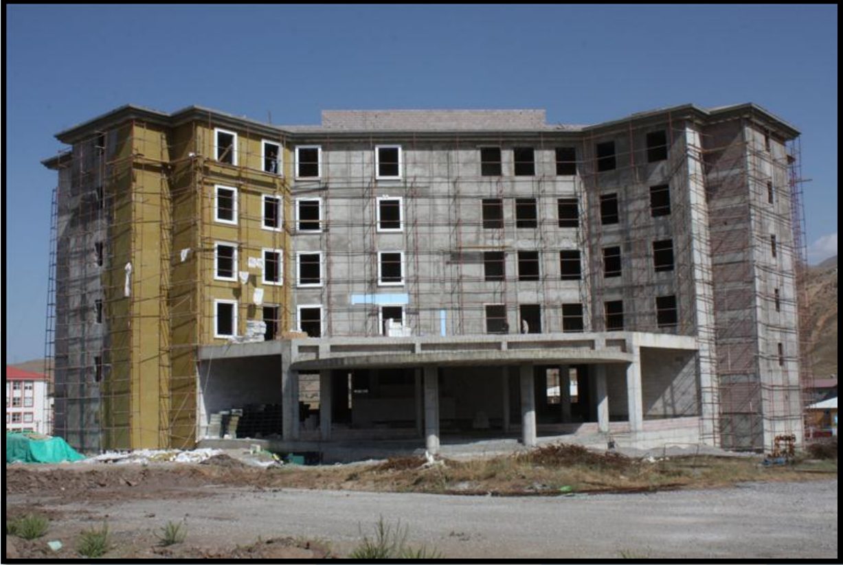
Fotoğraf 10. BEÜ Misafirhane İnşaatı 25.08.2012
