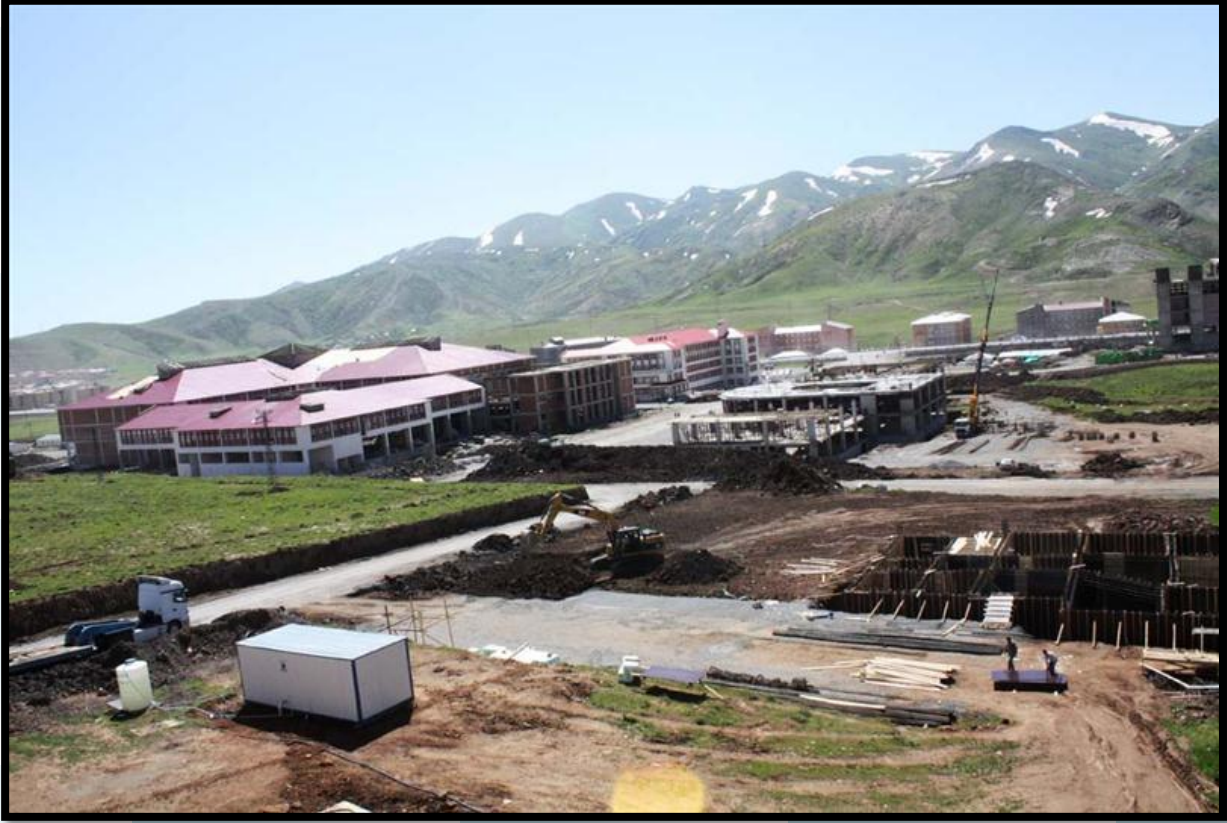
Fotoğraf 8. Kampüs Alanı İnşaatı 25.05.2012
