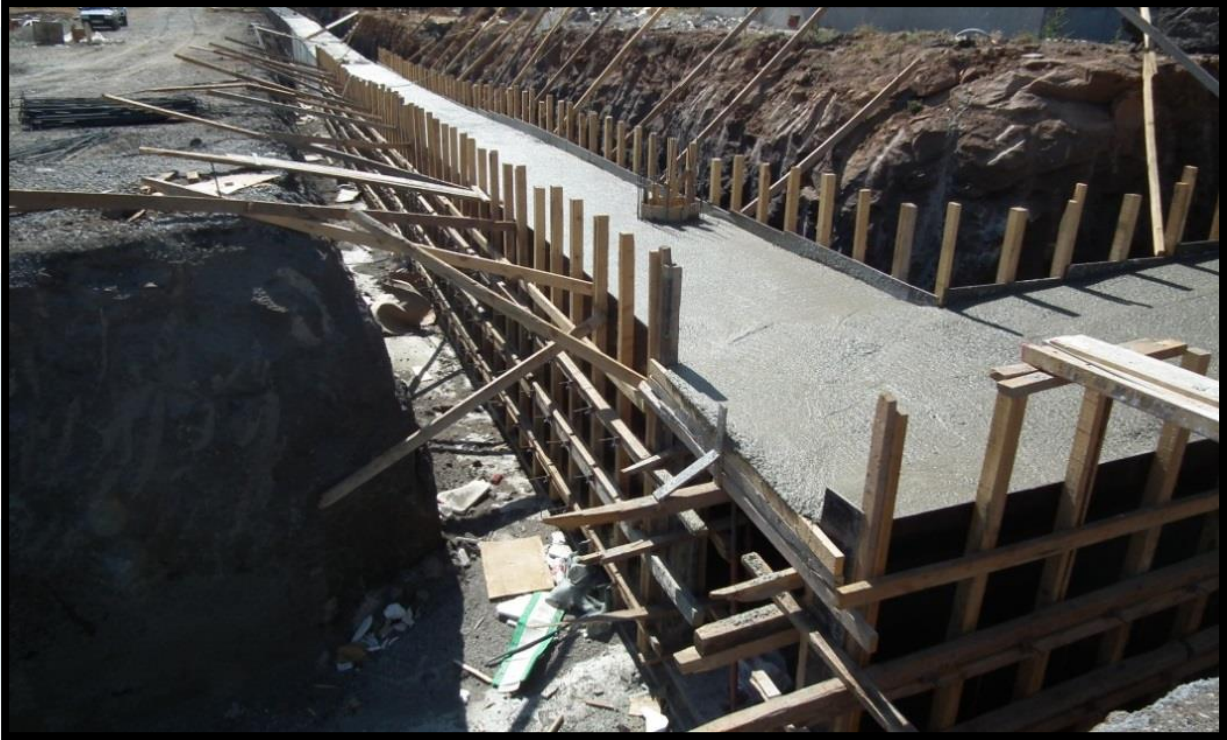
Fotoğraf 11. Altyapı Ve Trafo Merkezleri İnşaatı
