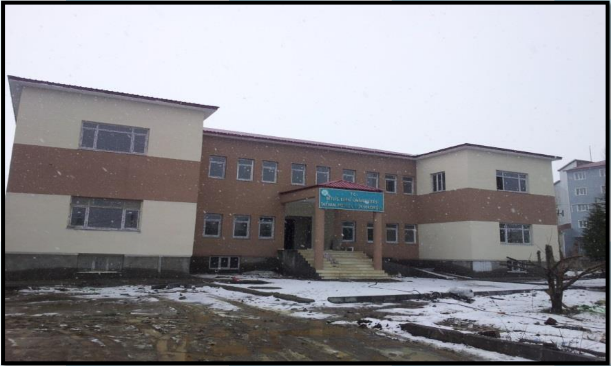
Fotoğraf 19. Tatvan Meslek Yüksekokulu Ek Bina İnşaatı
