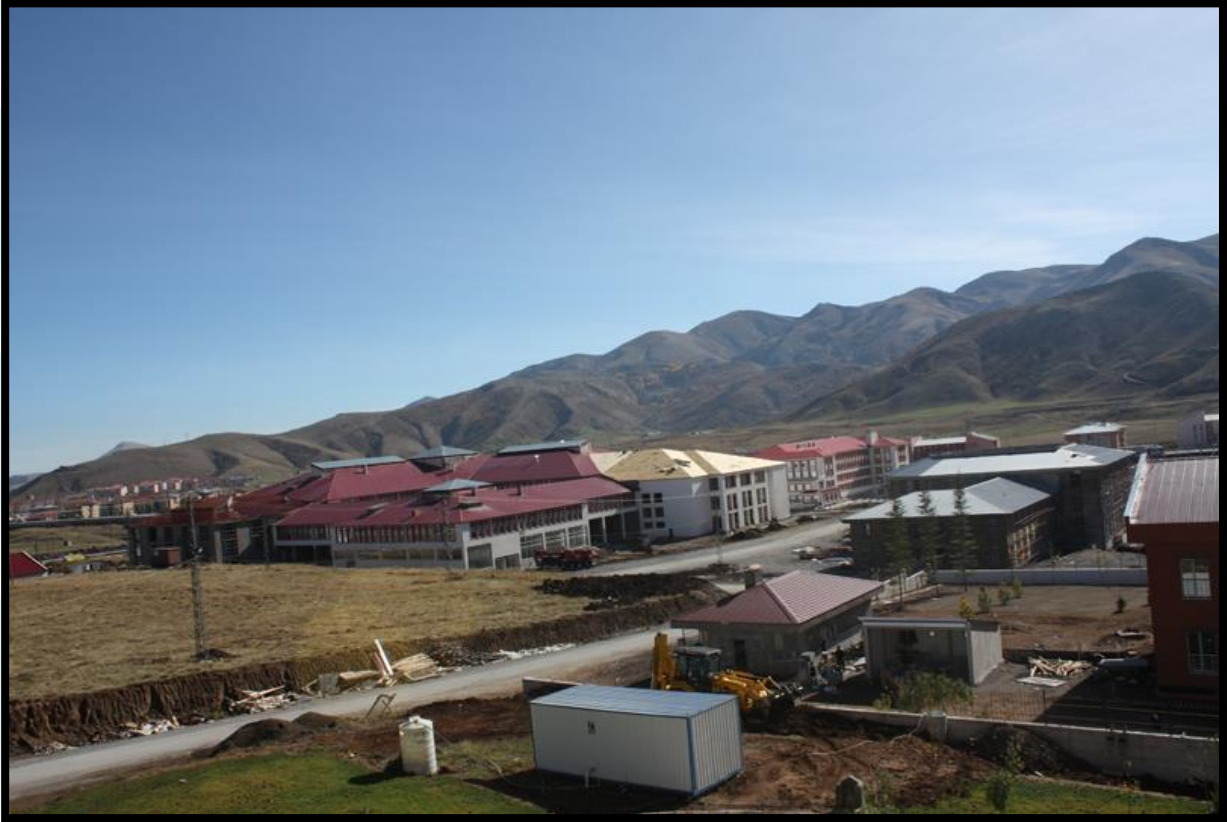
Fotoğraf 9. Kampüs Alanı İnşaatı 30.10.2012
