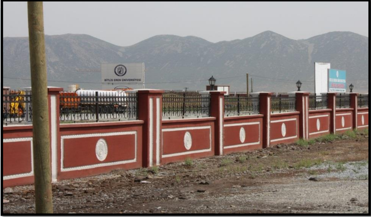
Fotoğraf 14.Çevre Duvarı Ve Panel Çit Yapımı
